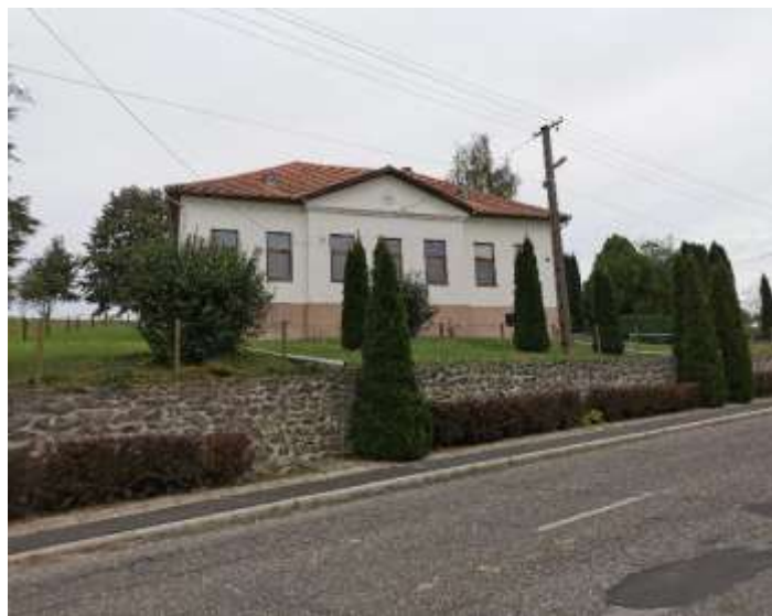
A Görögkatolikus Parókia épülete
